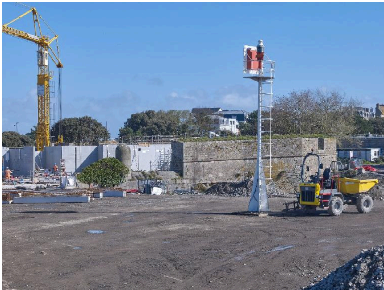
Vue du chantier du terre-plein du Naye (couverture photographique du 11 mars 2026). Au premier plan, un feu de signalisation du port. En arrière-plan, le fort du Naye
