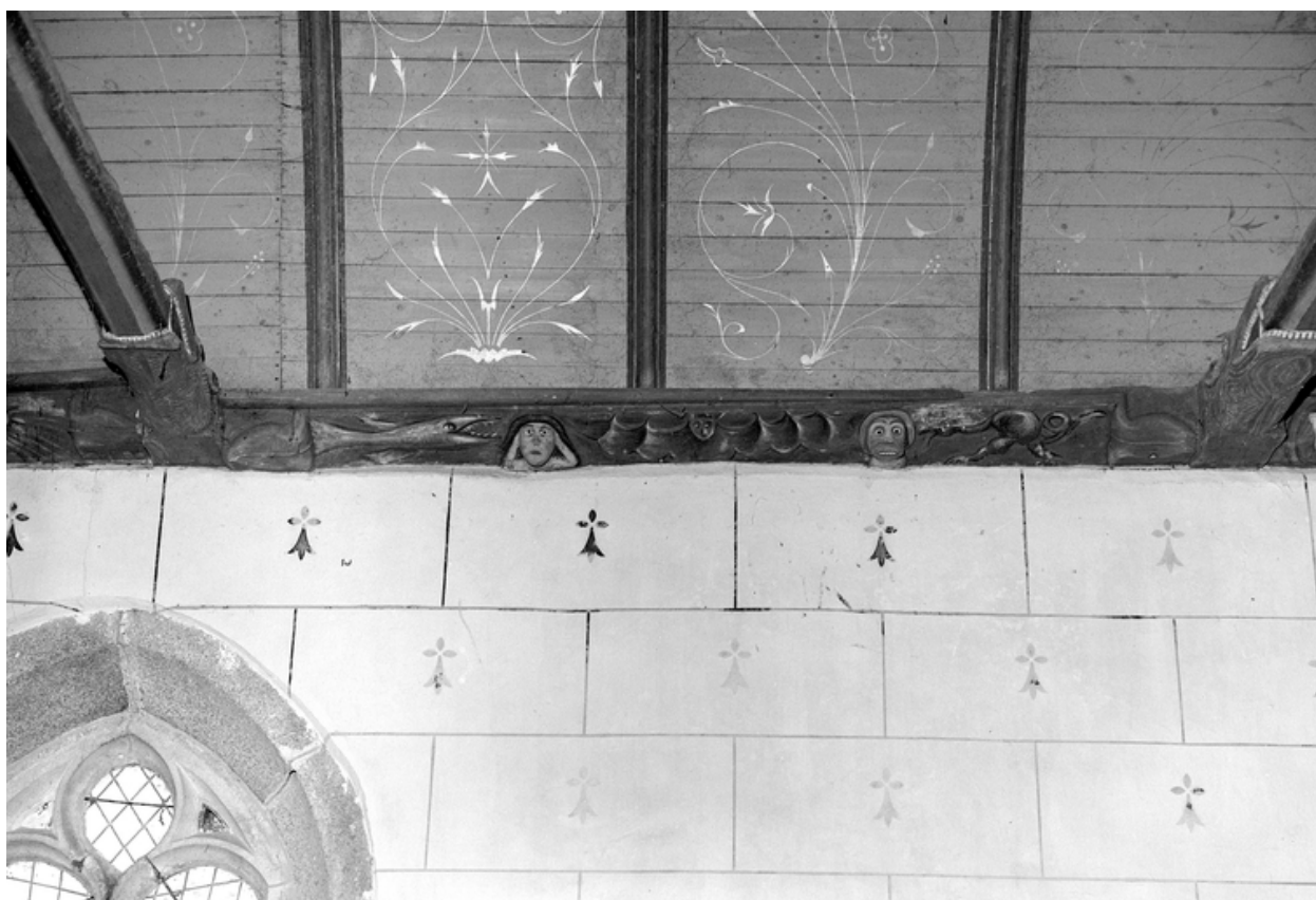
Nef, mur sud, sablière, d'ouest en est : 3ème motif
