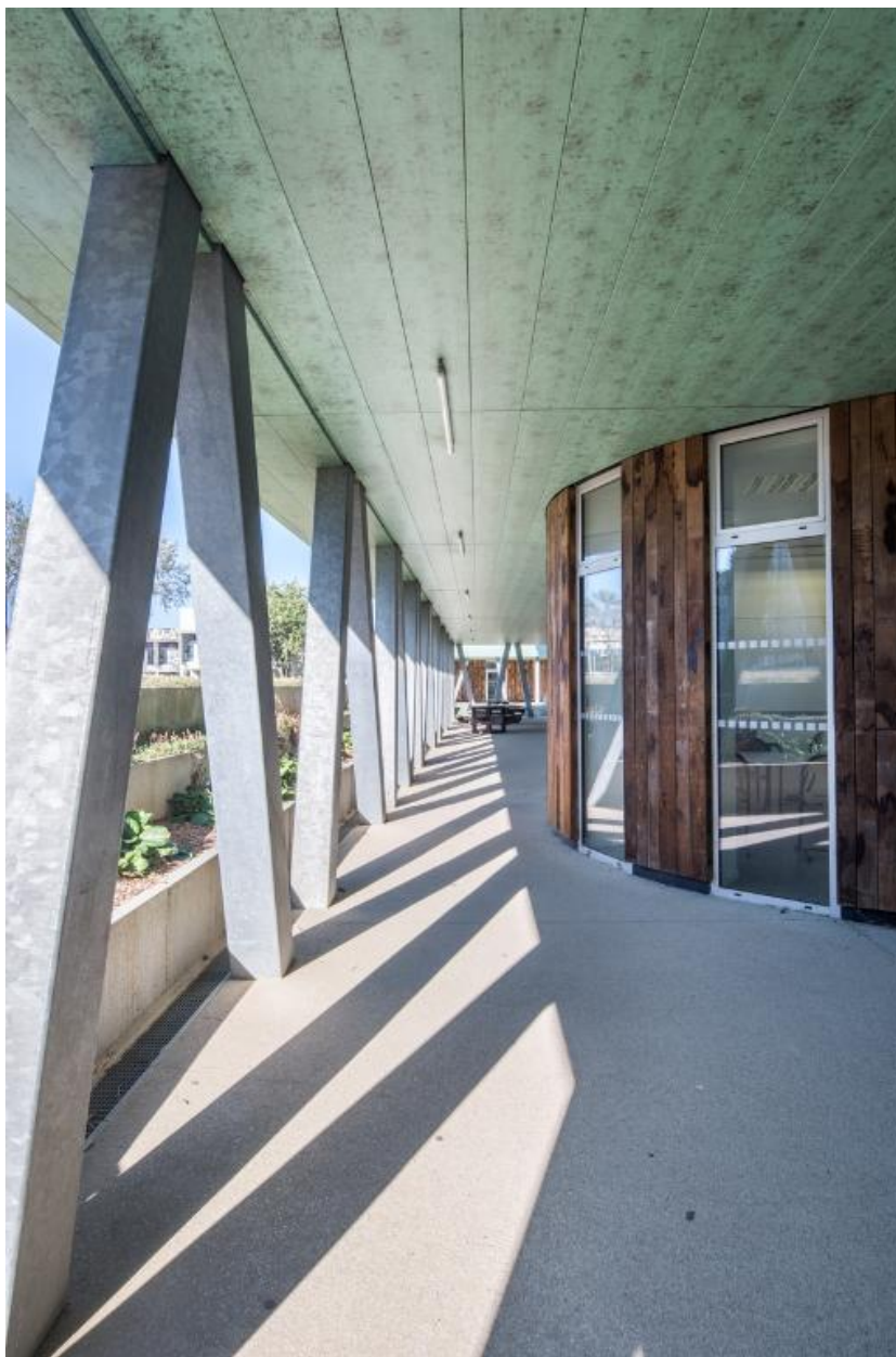
Galerie dans œuvre, au rez-de-chaussée de l'espace sciences (B2). Thierry Soquet, architecte, 2015
