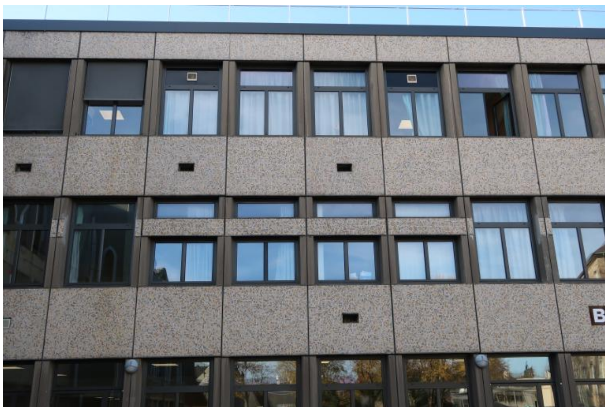
Bâtiment B, externat (Yves Moignet, architecte, 1975) : détail de la façade sur cour.
