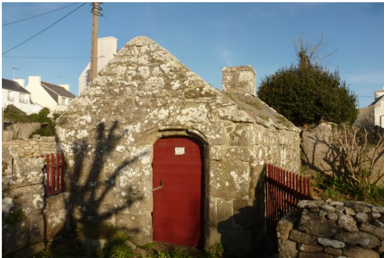
Four à pain situé le long de la départementale, pignon ouest. (2019)
