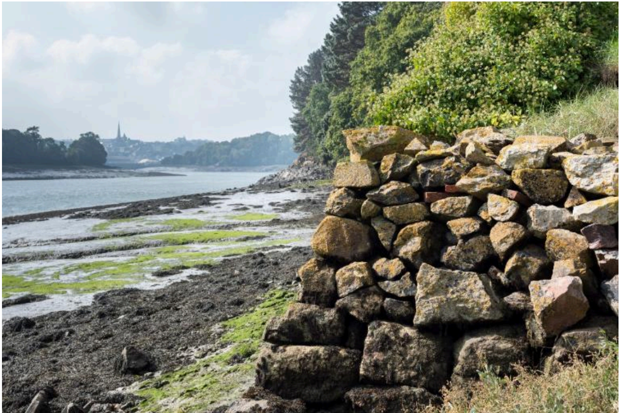
Vue de profil d'une partie de la cale en pierre sèche de Plouguiel sur la rive ouest du Jaudy
