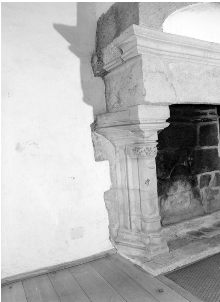
Tour sud-ouest, troisième niveau, piédroit de cheminée.
