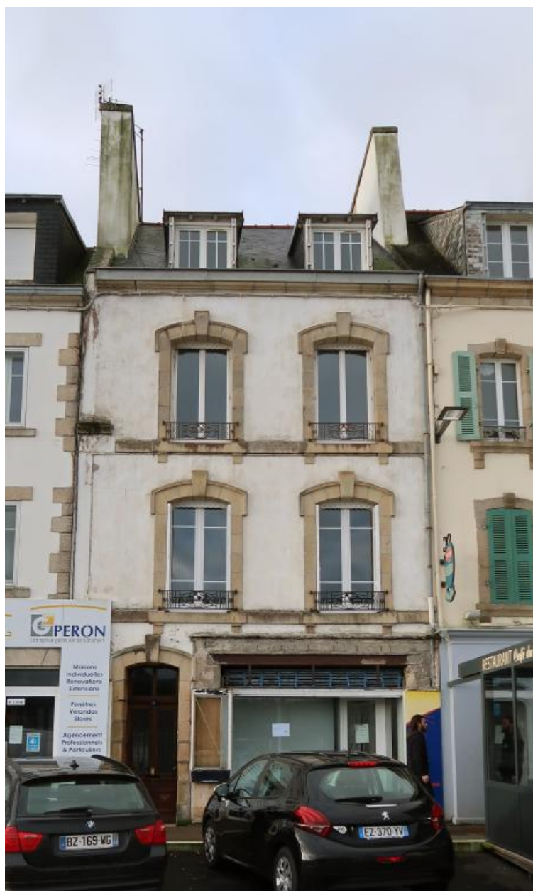
Immeuble au 9, quai Jean Jaurès, élévation antérieure. (2020)
