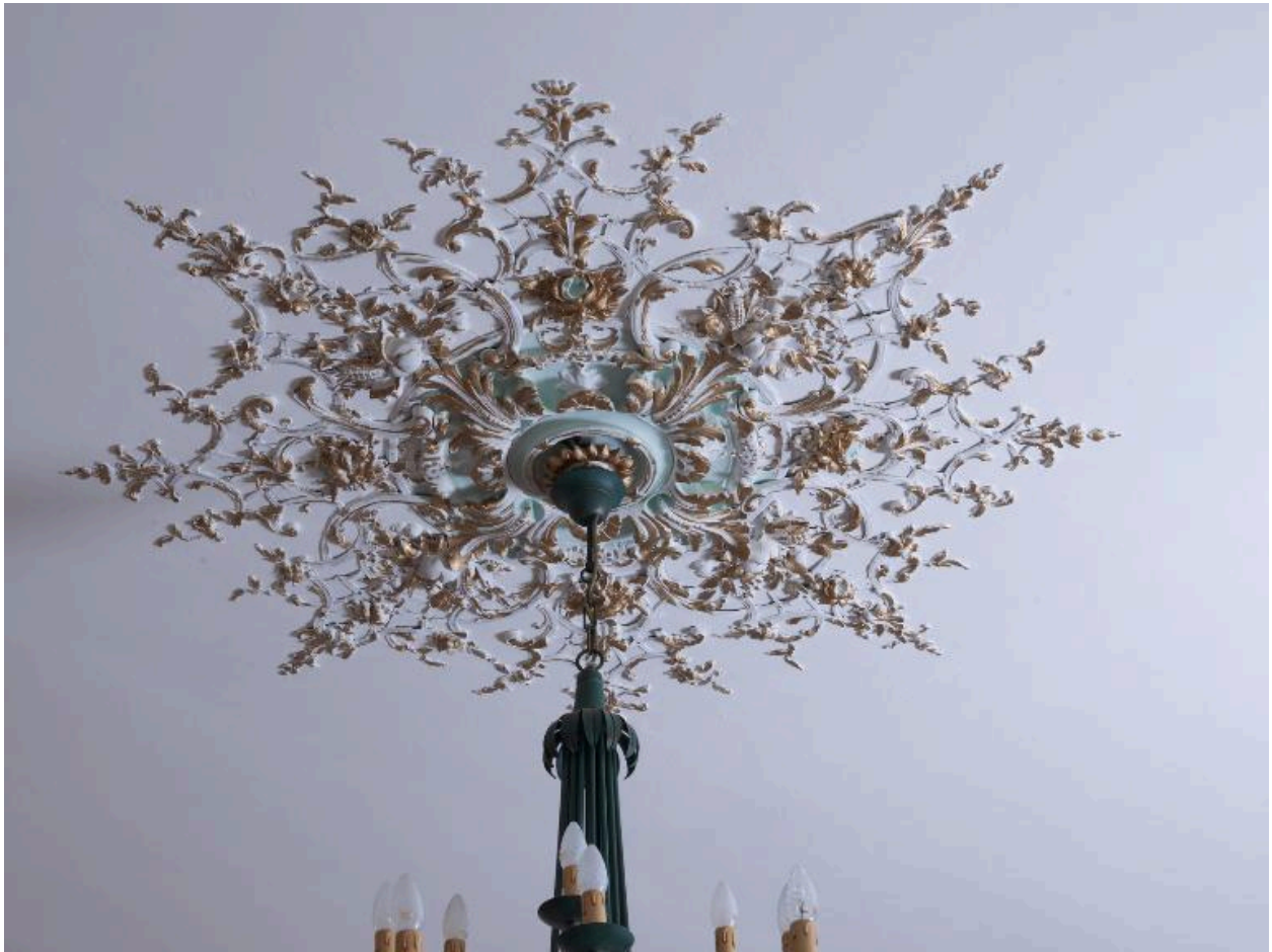
Rez-de-chaussée. Pièce à droite du hall d'entrée dite "salle Saint-Yves". Détail de la rosace du plafond
