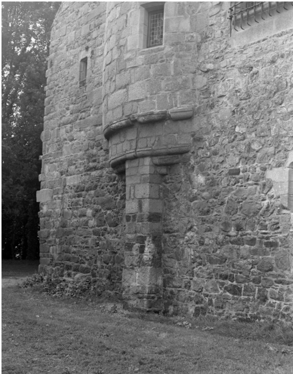
Vue de l'élévation postérieure côté Trieux : détail de la tour sud-est (état en 1974)
