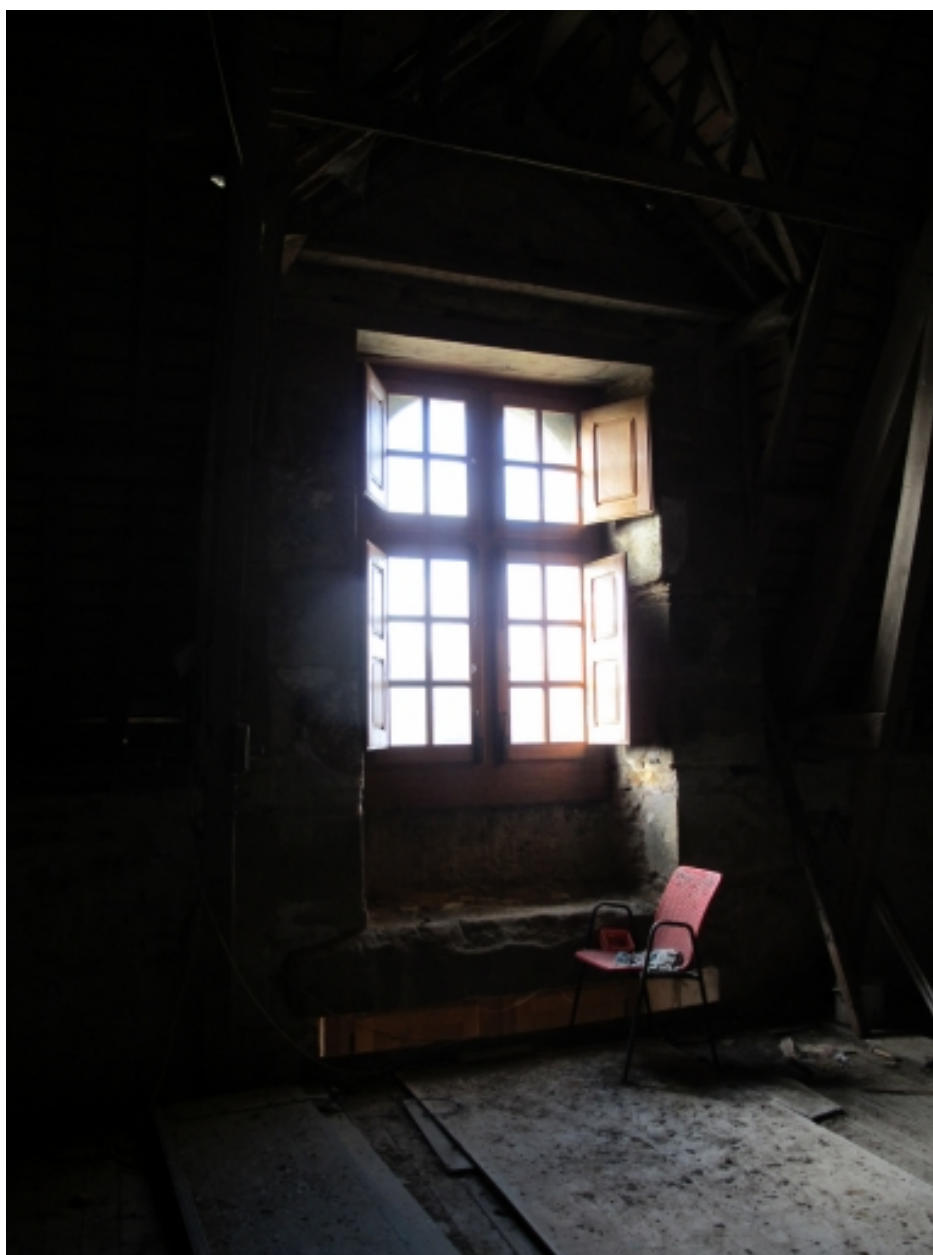
Lucarne du comble du pavillon
