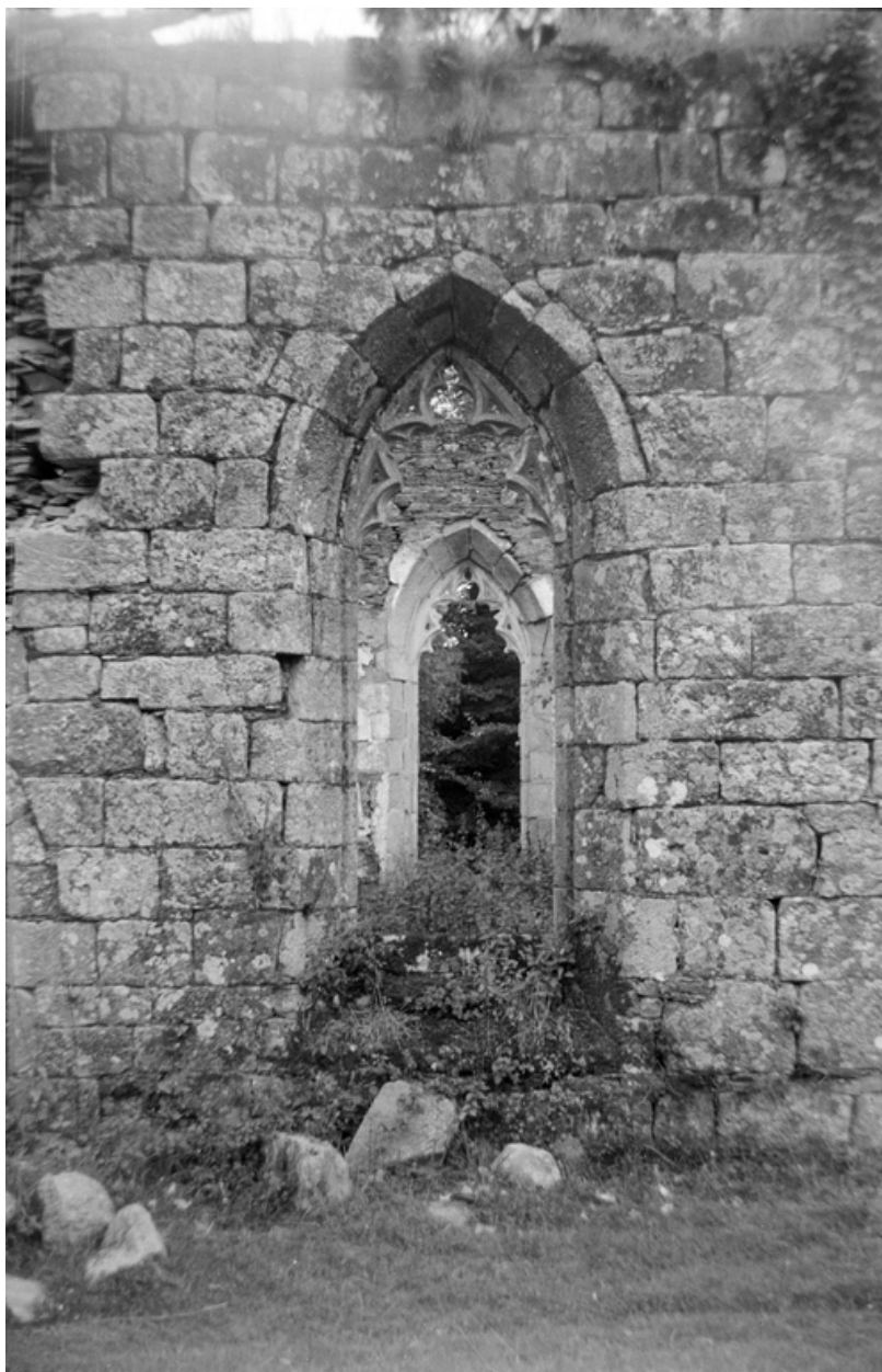
Elévation sud, détail d'une travée (à droite) : état vers 1955
