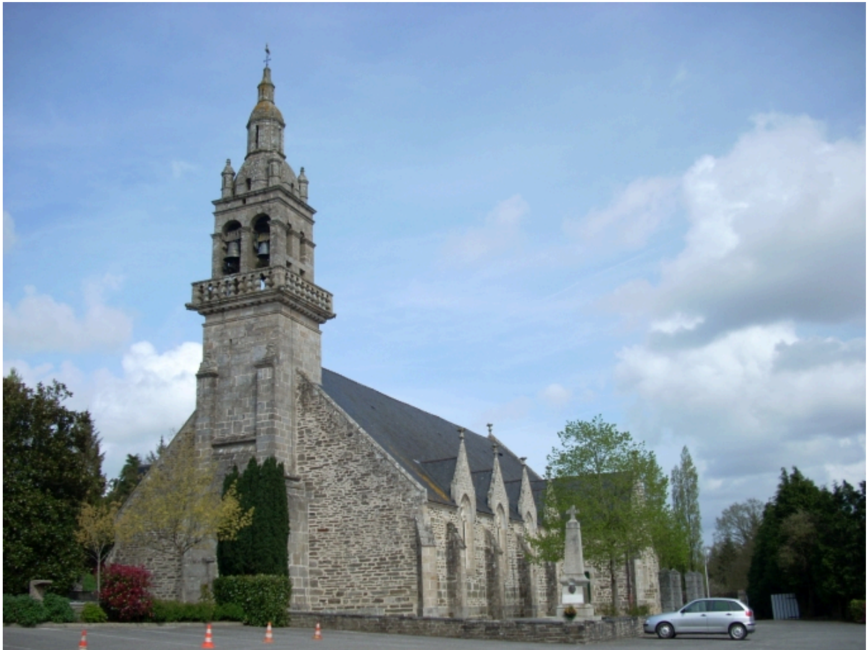
Landeleau, église paroissiale Saint-Théleau : vue générale sud-ouest
