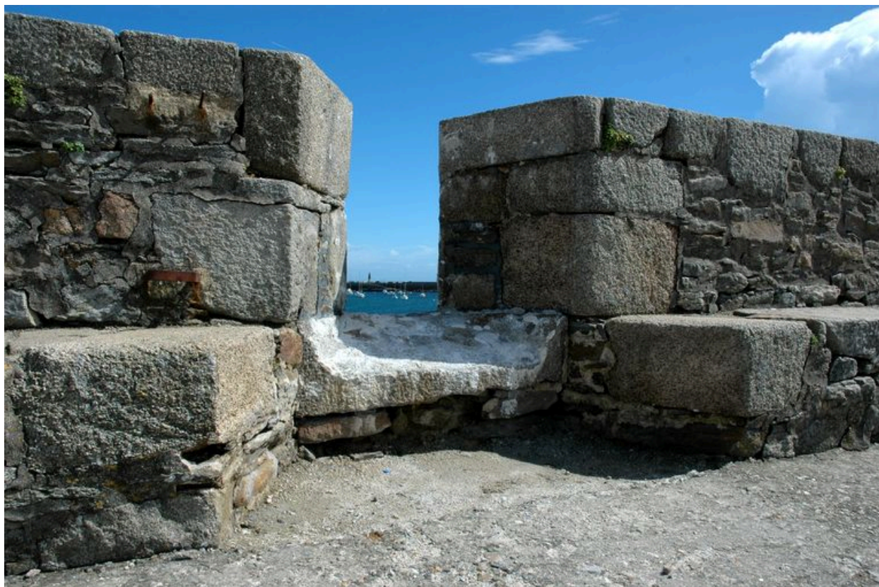
Vue de l'embrasure débouchée (état en 2004)
