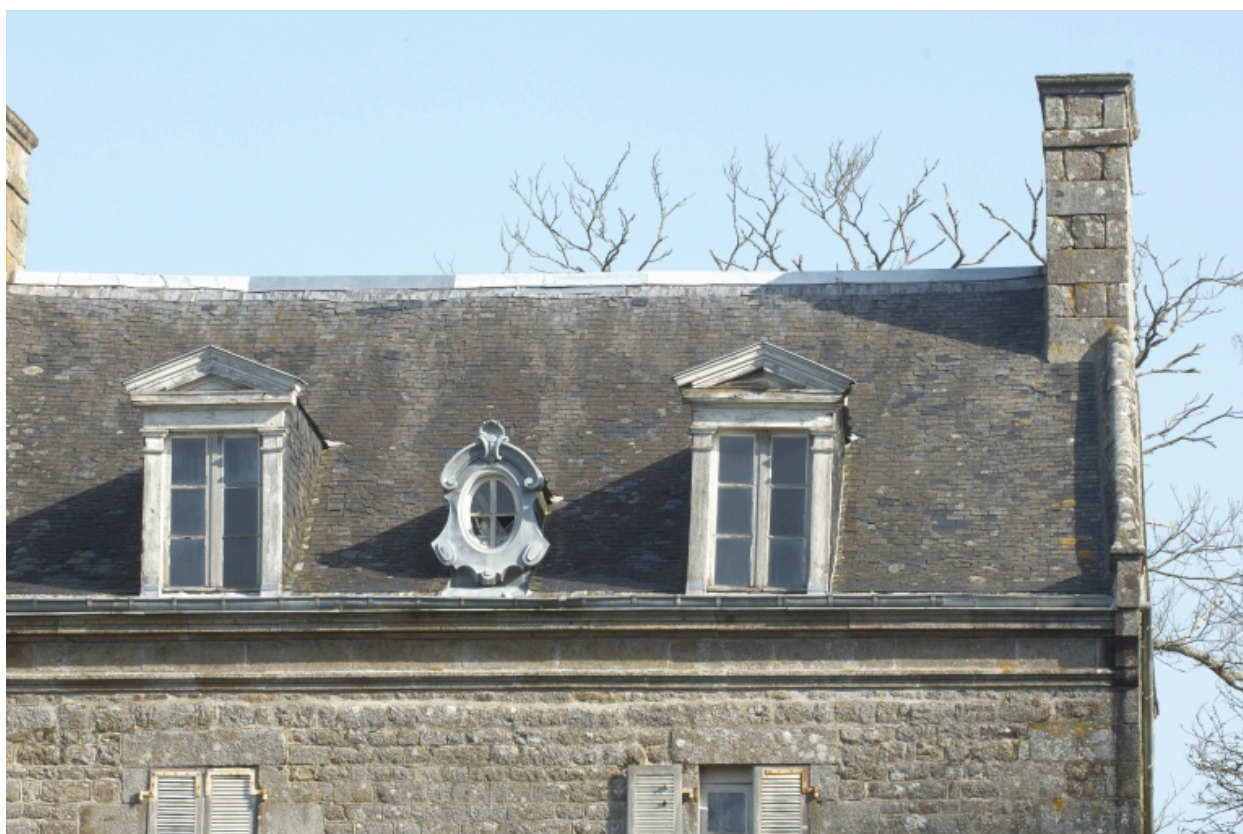
Détail des toitures
