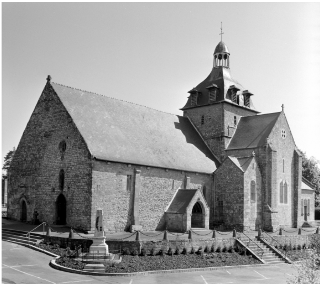
Elévation sud-ouest : vue générale
