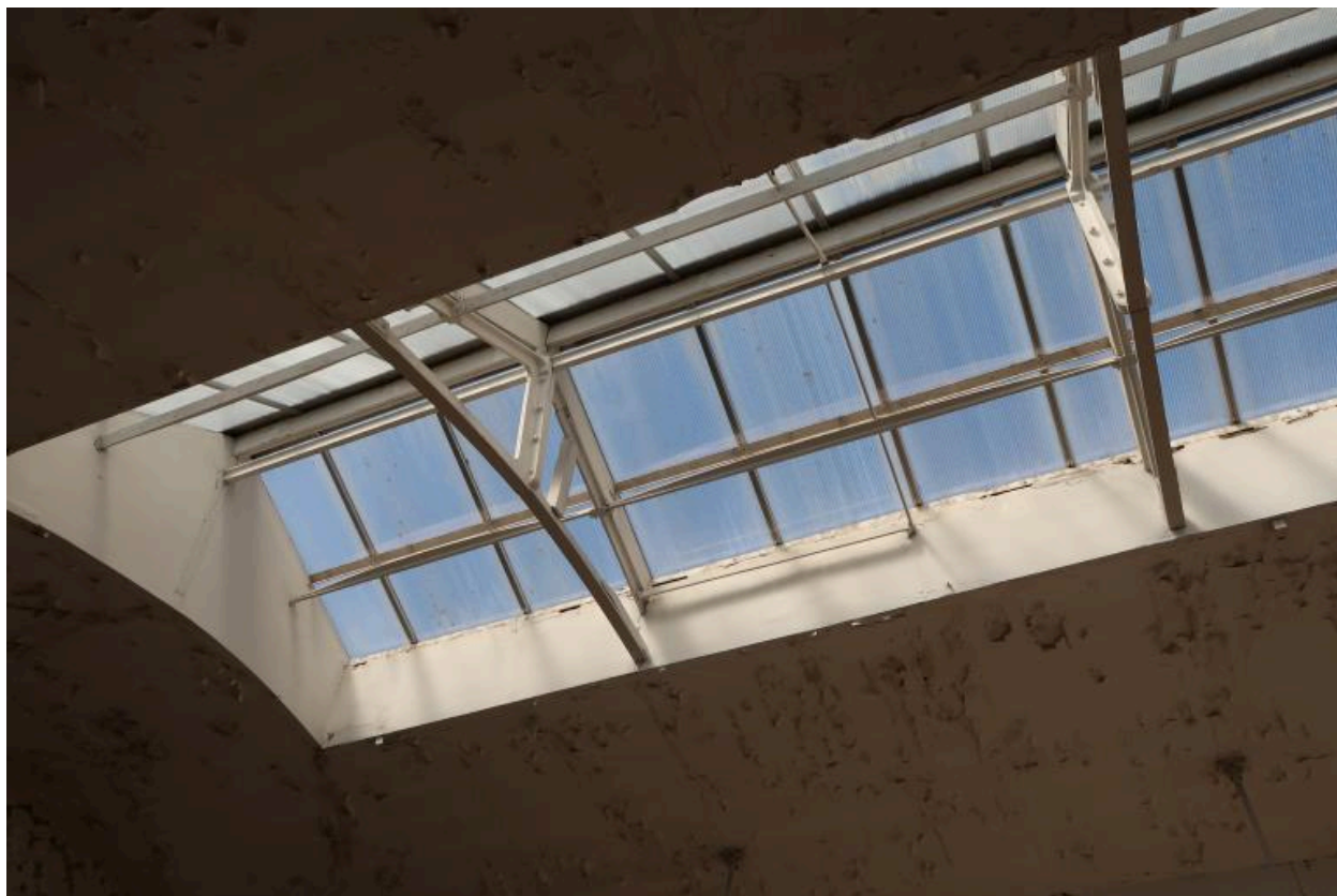
Vue intérieure : partie ouest, charpente métallique et lanterneau (état en 2022)
