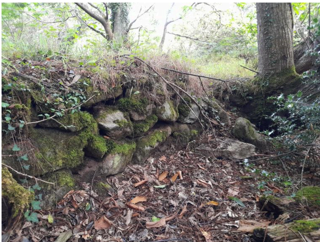
Mur 7, parement est. Détail de la maçonnerie.
