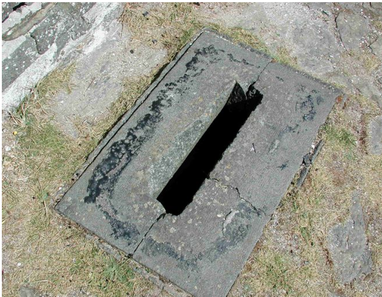
Vue du réduit de batterie de côte de l'île de l'Aber : terrasse, créneau de fusillade vertical type assomoir (dispositif de défense de l'entrée)
