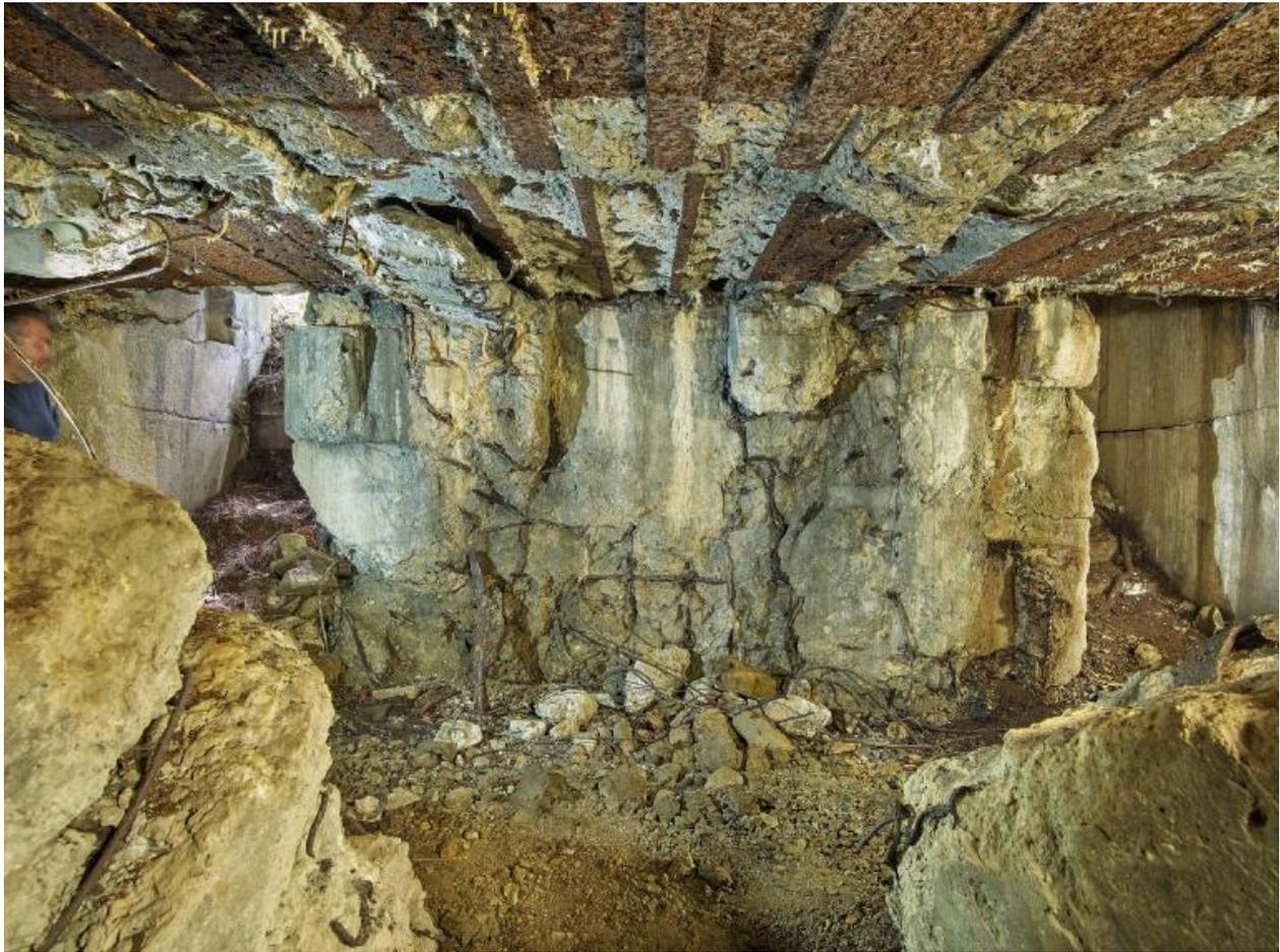
Vue du bunker - abri de type 502 situé à l'extrémité Est de la pointe : sas après explosion. De part et d'autre du sas se trouvent les entrées du bunker. Au centre, le ferrailage du bunker est particulièrement visible du fait de l'explosion
