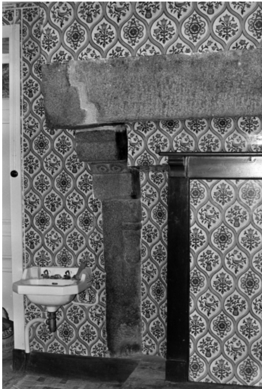
Cheminée du rez-de-chaussée
