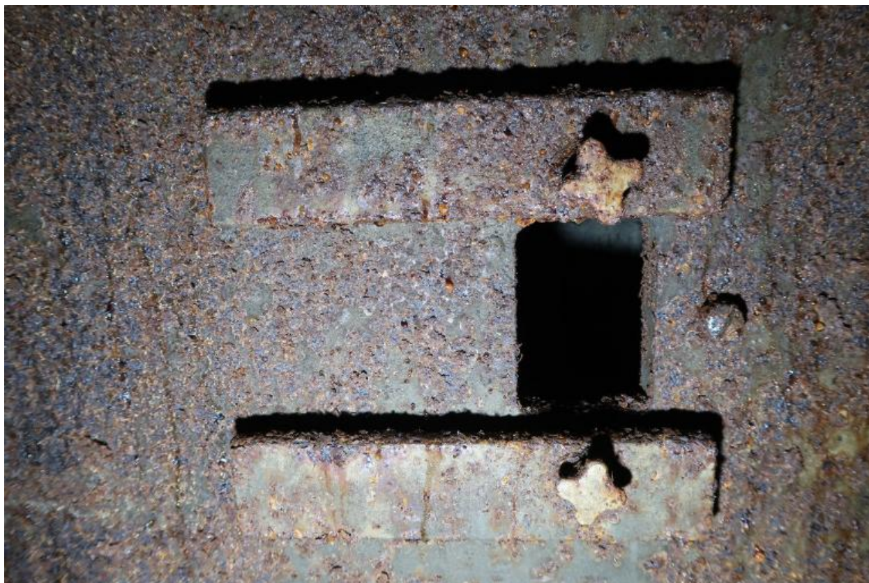
Vue de la petite salle située au nord-est : détail du judas de la porte blindée
