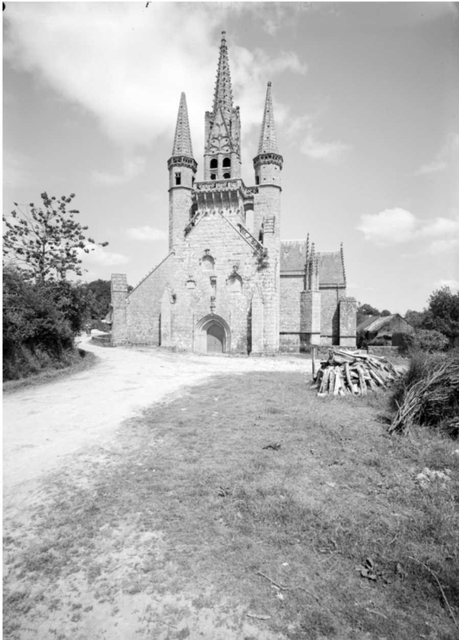
Façade ouest, vue générale.
