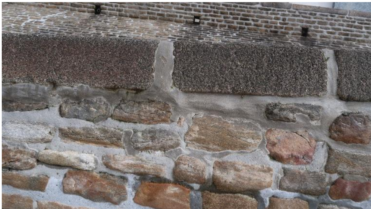
Matériaux et maçonnerie de la cale du port de la Croix
