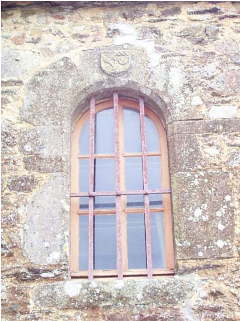
Sacristie nord, fenêtre du 16e siècle sculptée d'un blason : détail
