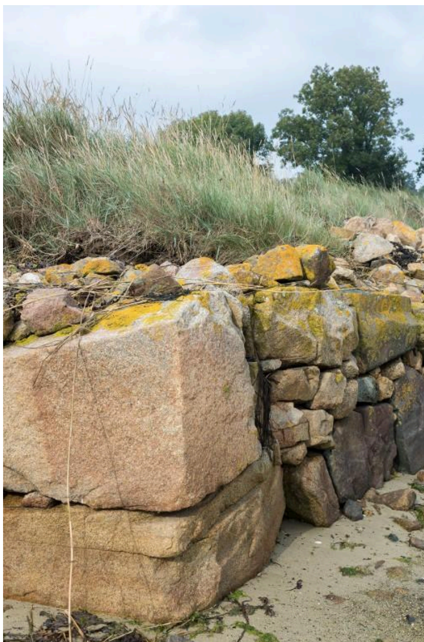
Détail de gros blocs de granite d'un mur de soutènement au fond de l'anse de Pelinec
