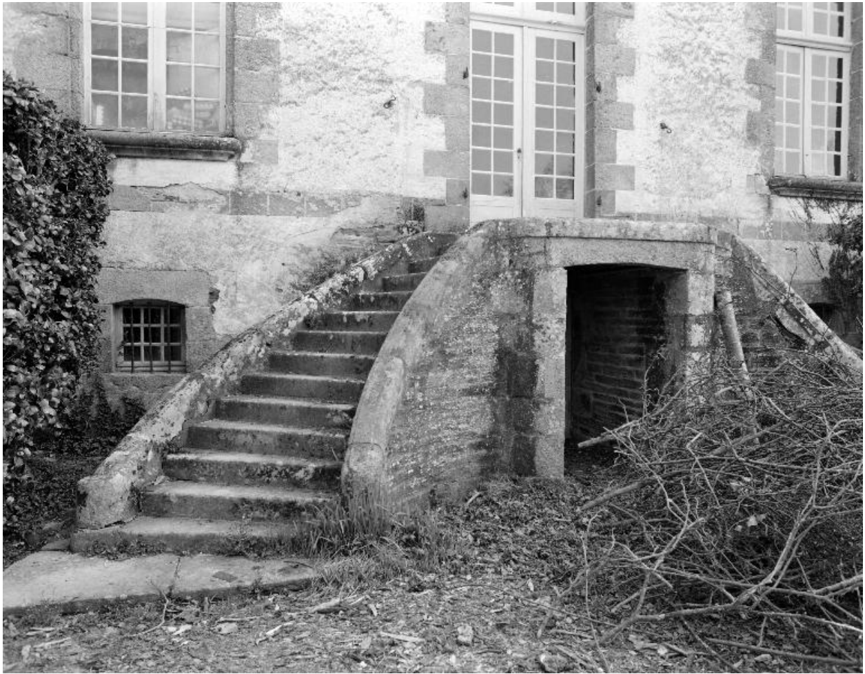
Château, logis : escalier extérieur ouest (état en 1984)
