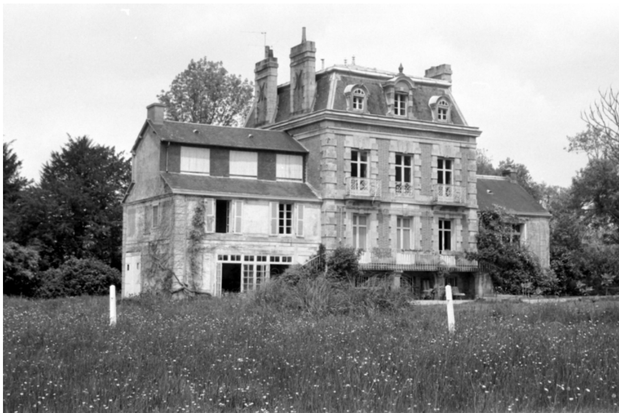
Vue générale de la façade antérieure
