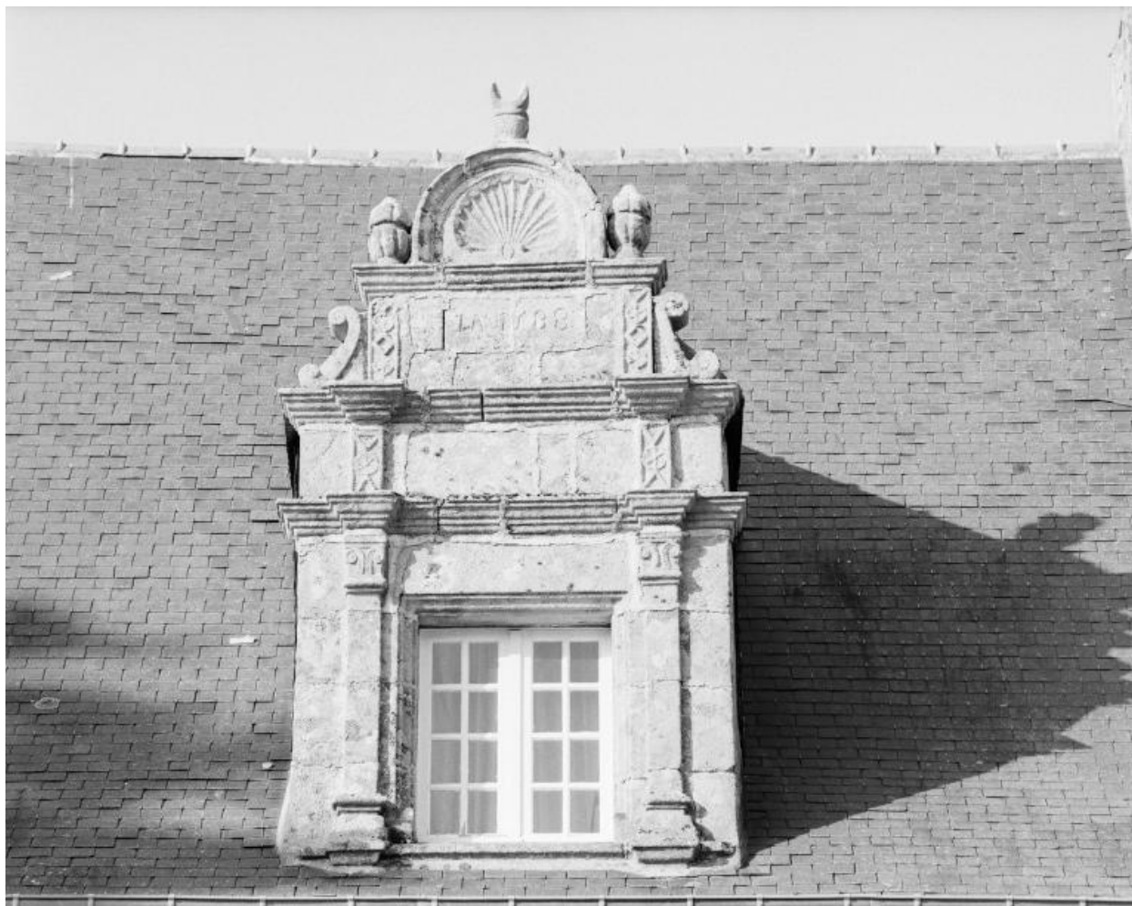
Elévation est, lucarne.
