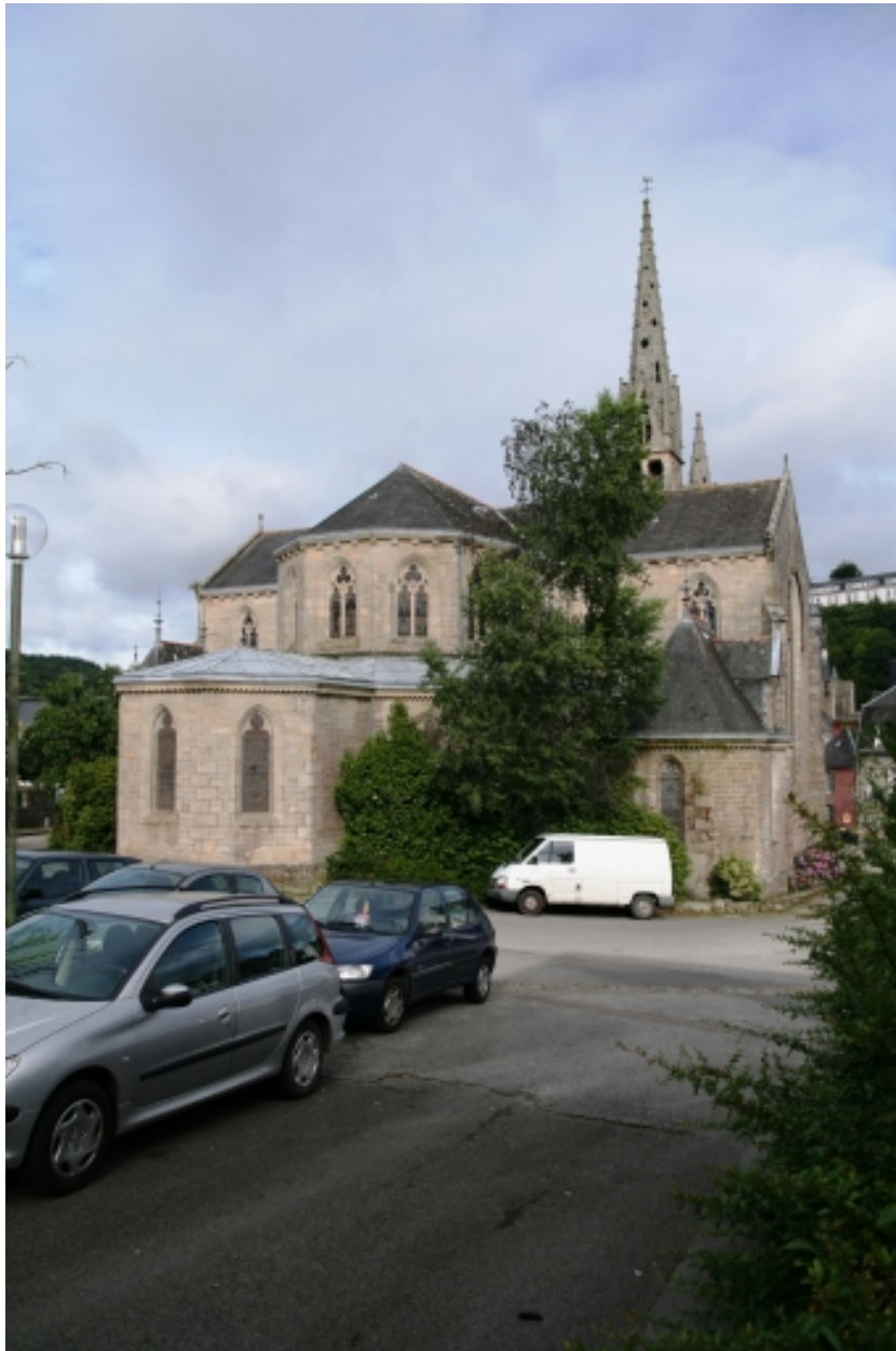
Châteaulin, église paroissiale Saint-Idunet : vue générale nord-est
