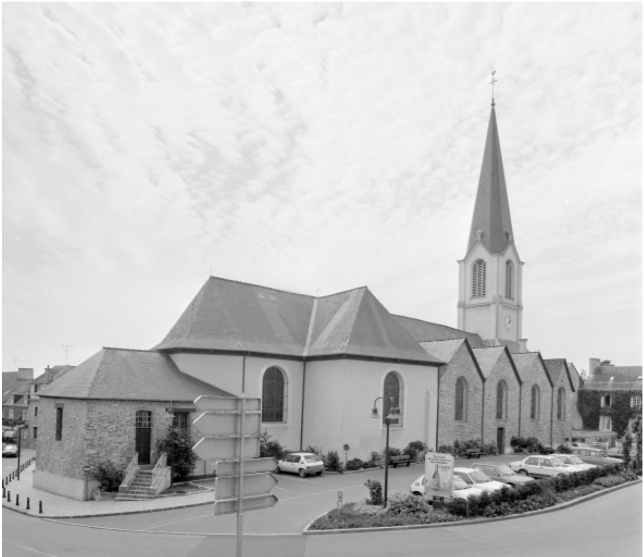
Elévation nord-est : vue générale
