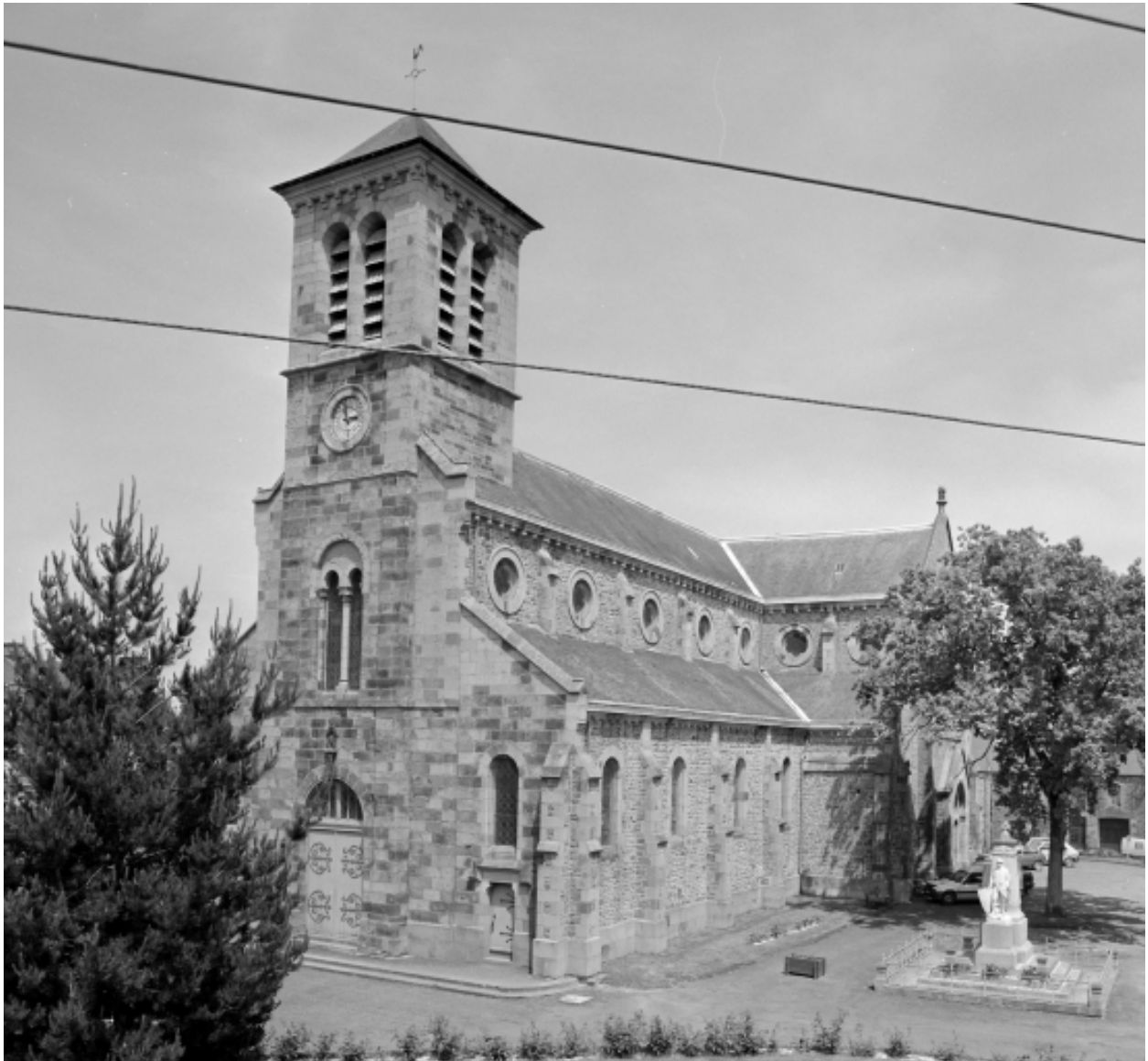
Elévation Sud-Ouest : vue générale
