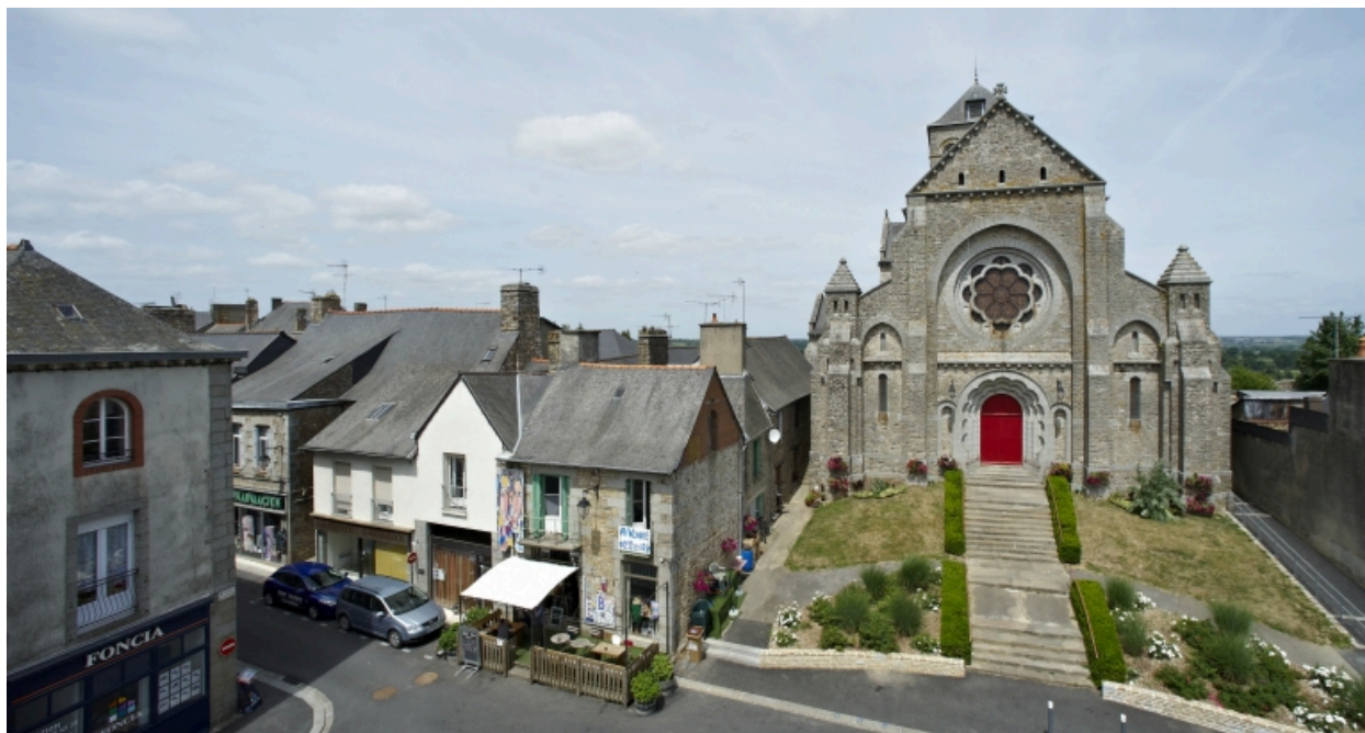
Vue générale sud
