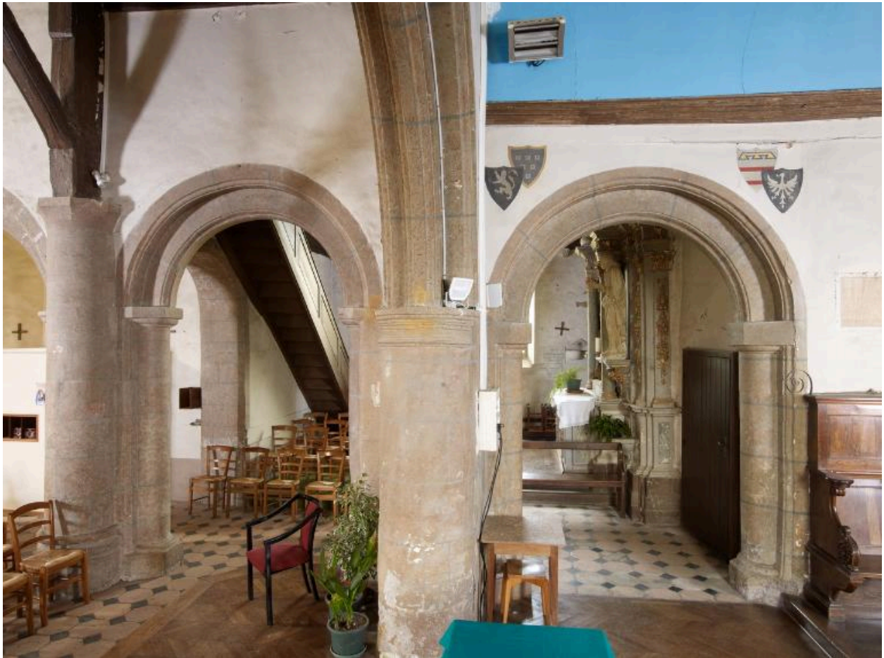
Vue nord depuis la croisée du transept
