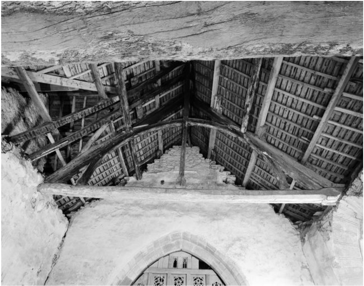
Chapelle, la nef : la charpente entre le carré du transept et le mur diaphragme (état en 1992)
