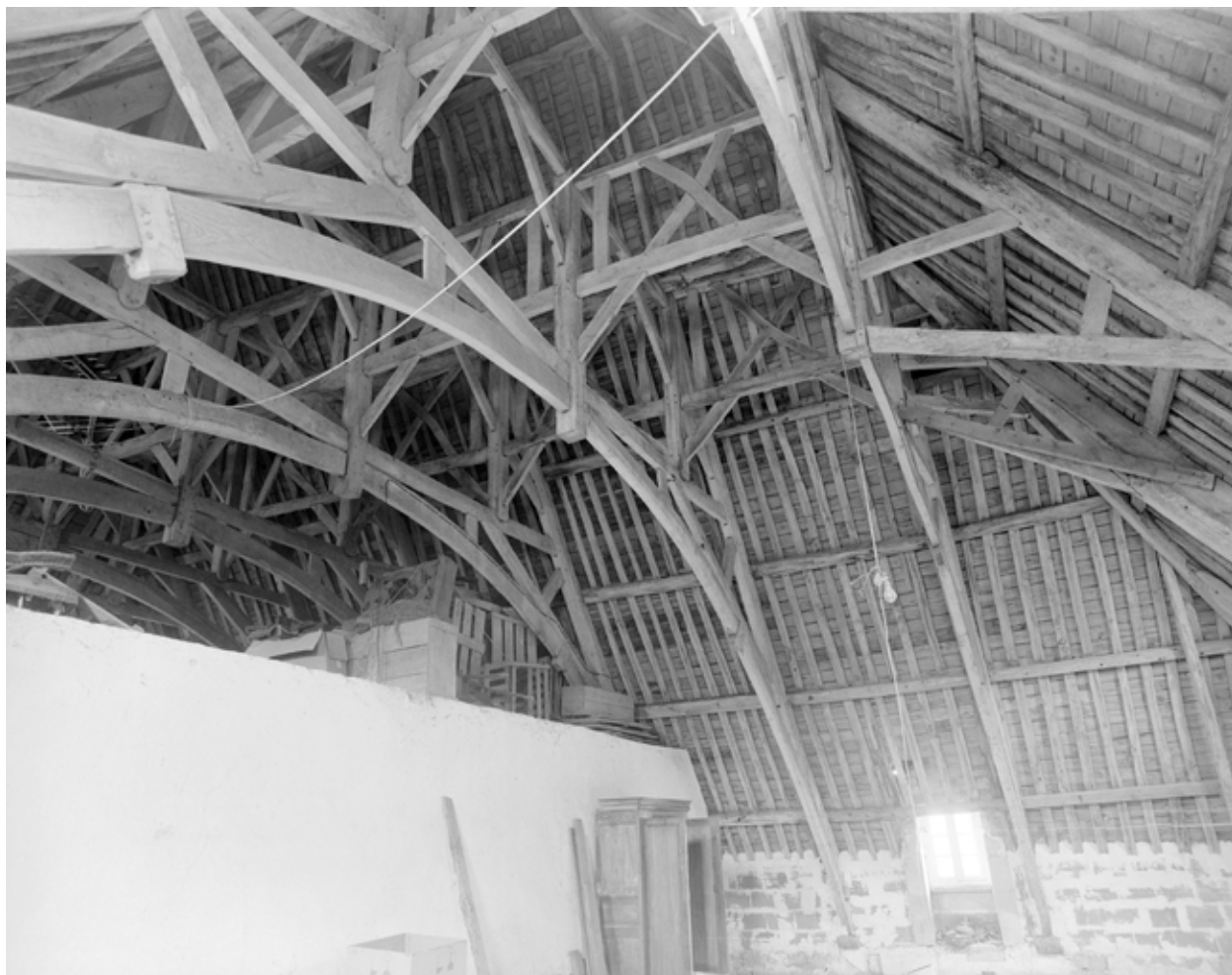
Vue générale de la charpente.
