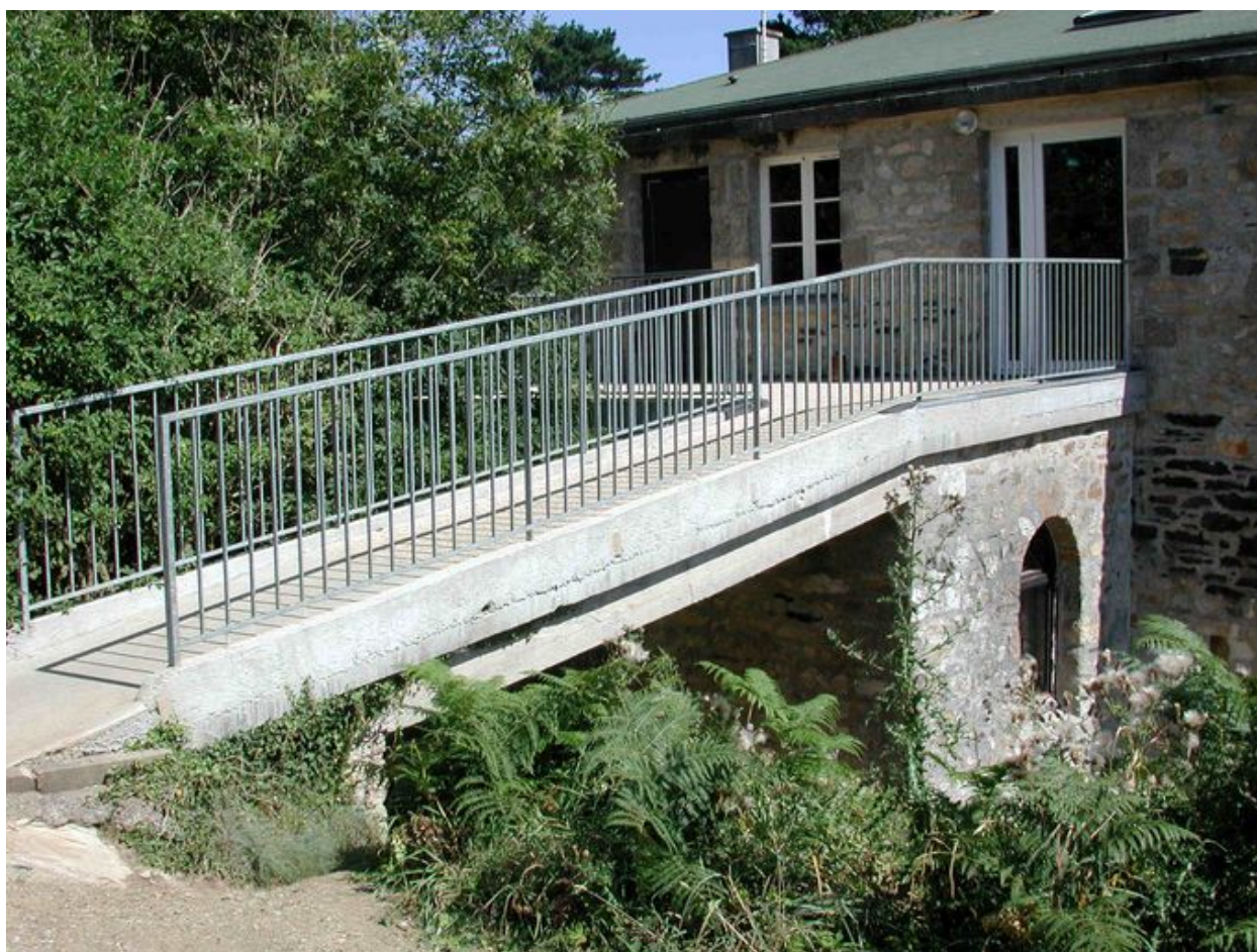
Vue du réduit de batterie de côte de Postolonnec aujourd'hui transformé en centre de colonies de vacances : galerie d'accès au premier étage
