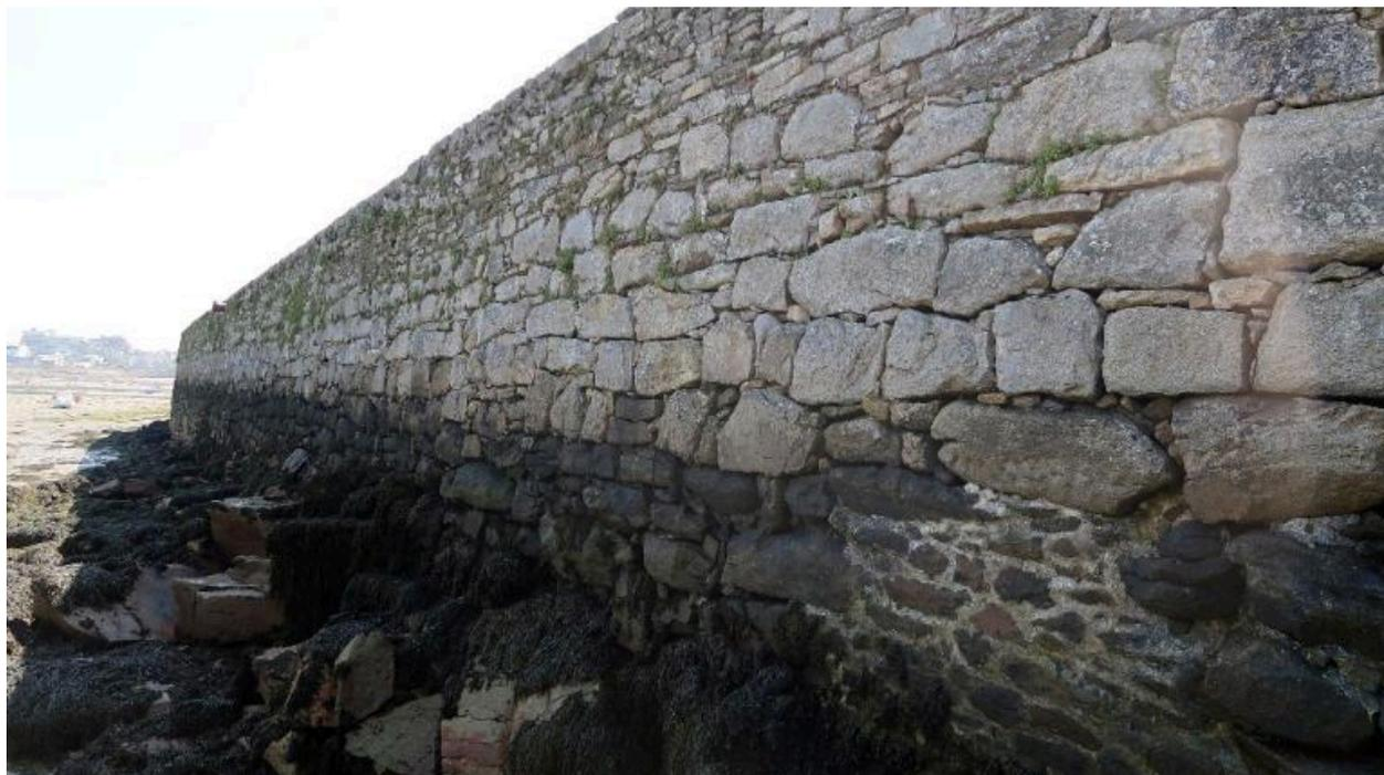
Vue générale du mur Nord de soutènement en pierres sèches
