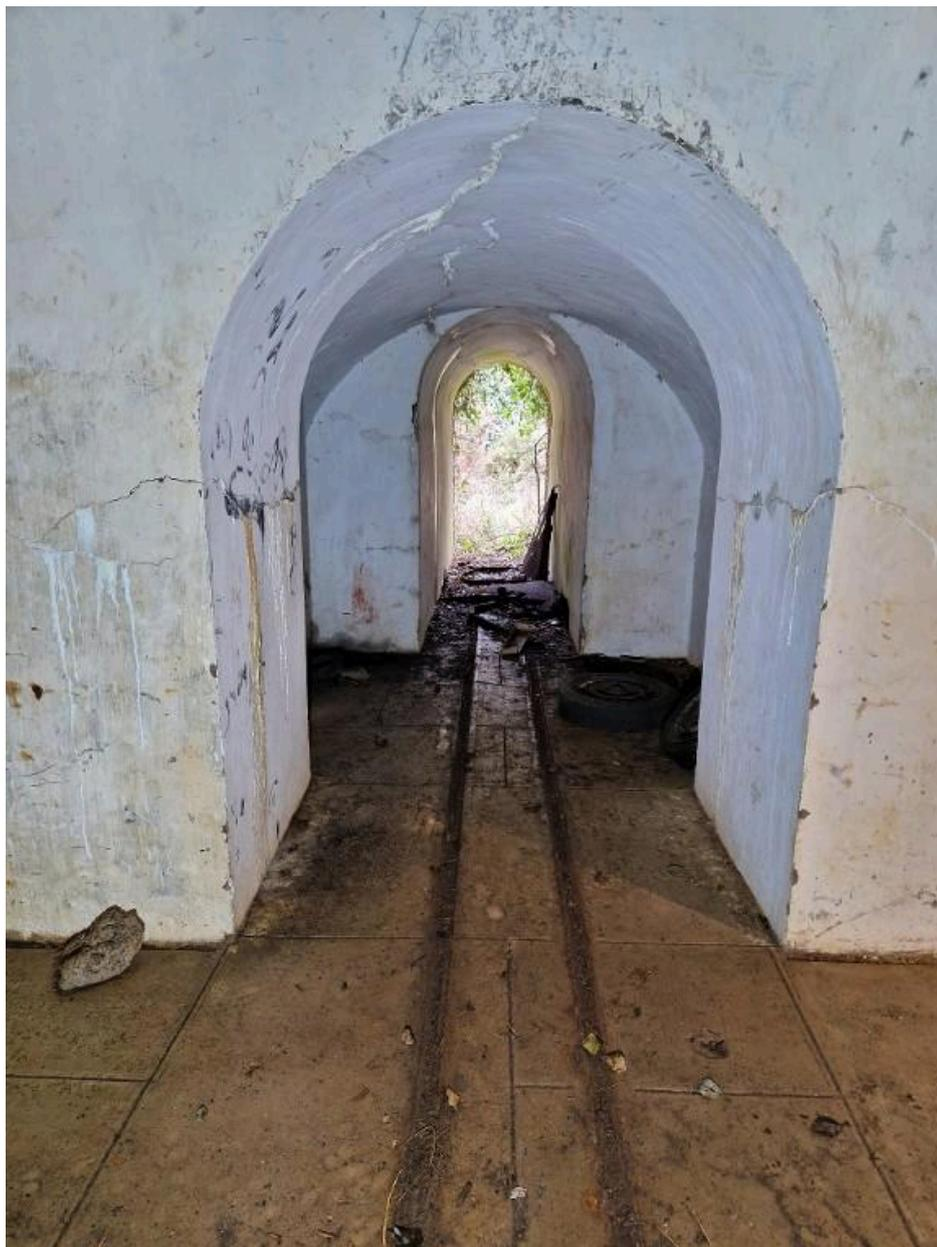
Vue intérieure du magasin à munitions : entrée est avec au sol une voie ferrée de 40 cm d'écartement pour le transport des munitions sur wagonnet. Un palan prend ensuite le relai pour la manutention des obus via un palan
