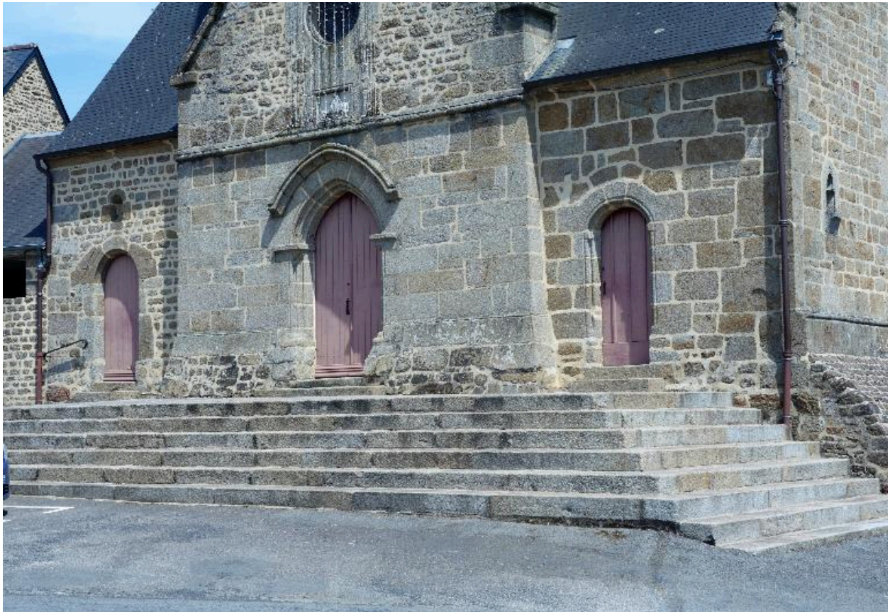
Façade ouest de l'église
