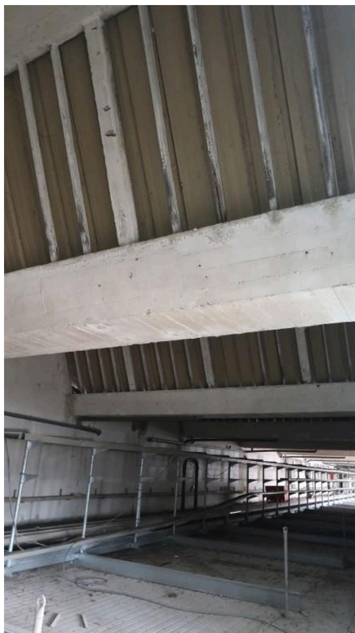
Criée de Concarneau : vue intérieure des sheds
