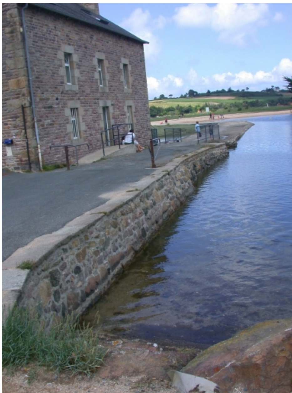
Vue de la digue du moulin
