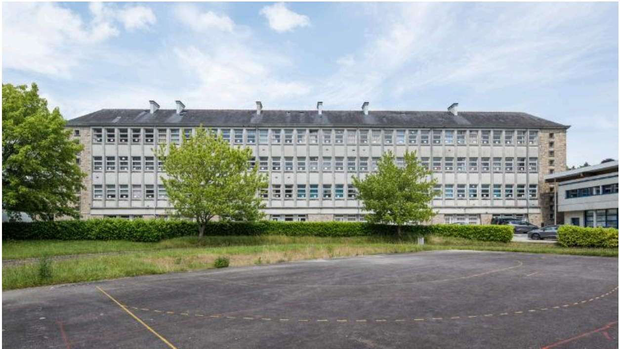
Externat, façade sud. Jacques Lachaud, architecte, 1962.
