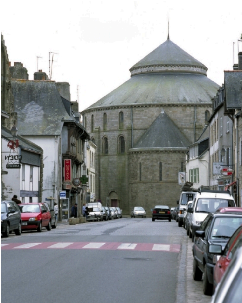
Rue Brémond d'Ars et élévation nord de l'édifice
