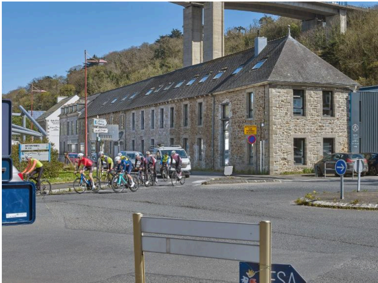
Alignement de bâtis construits à partir de 1847
