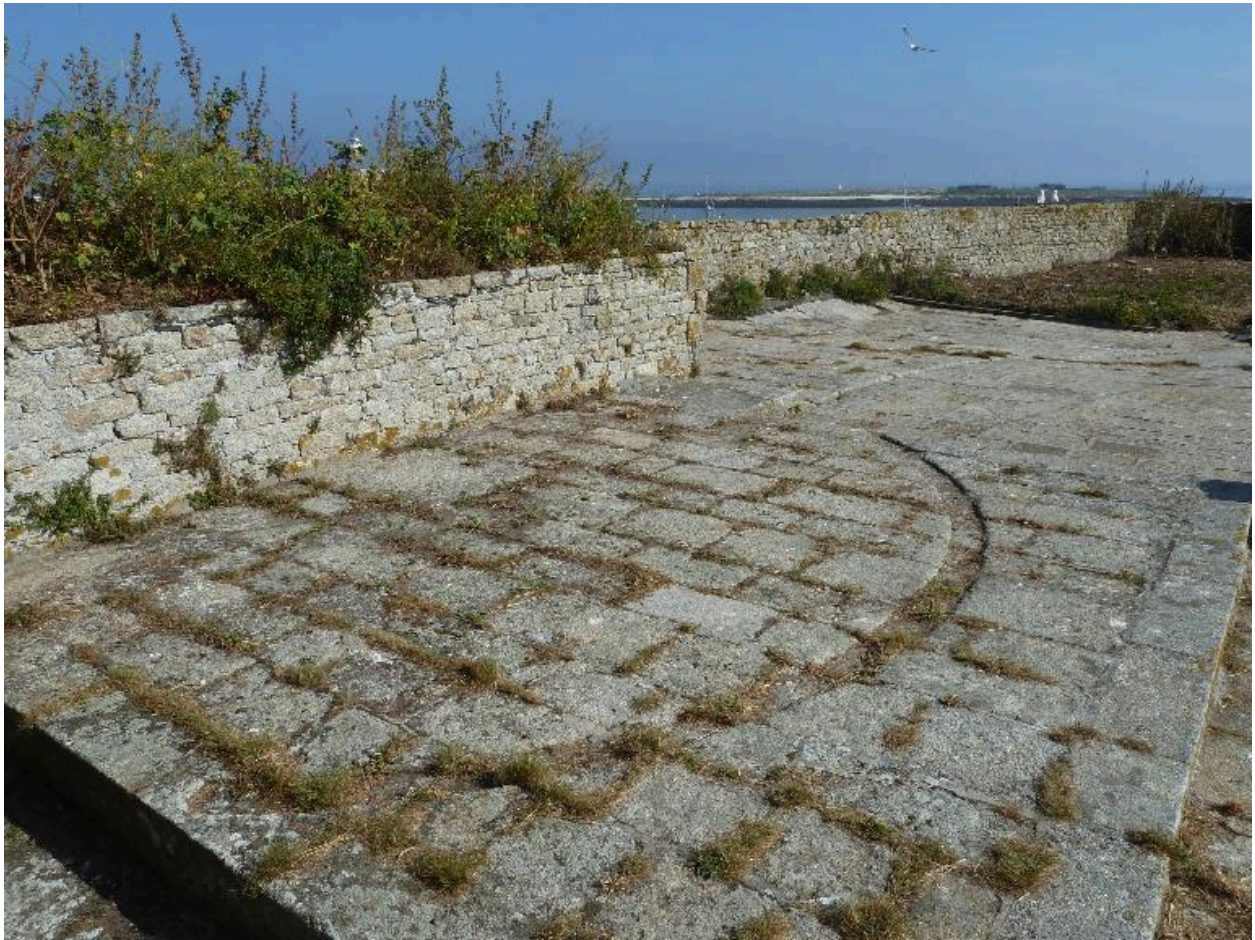
Archipel de Glénan, fort de l'île Cigogne, batterie Ouest, plate-forme nord et mur de genouillère.
