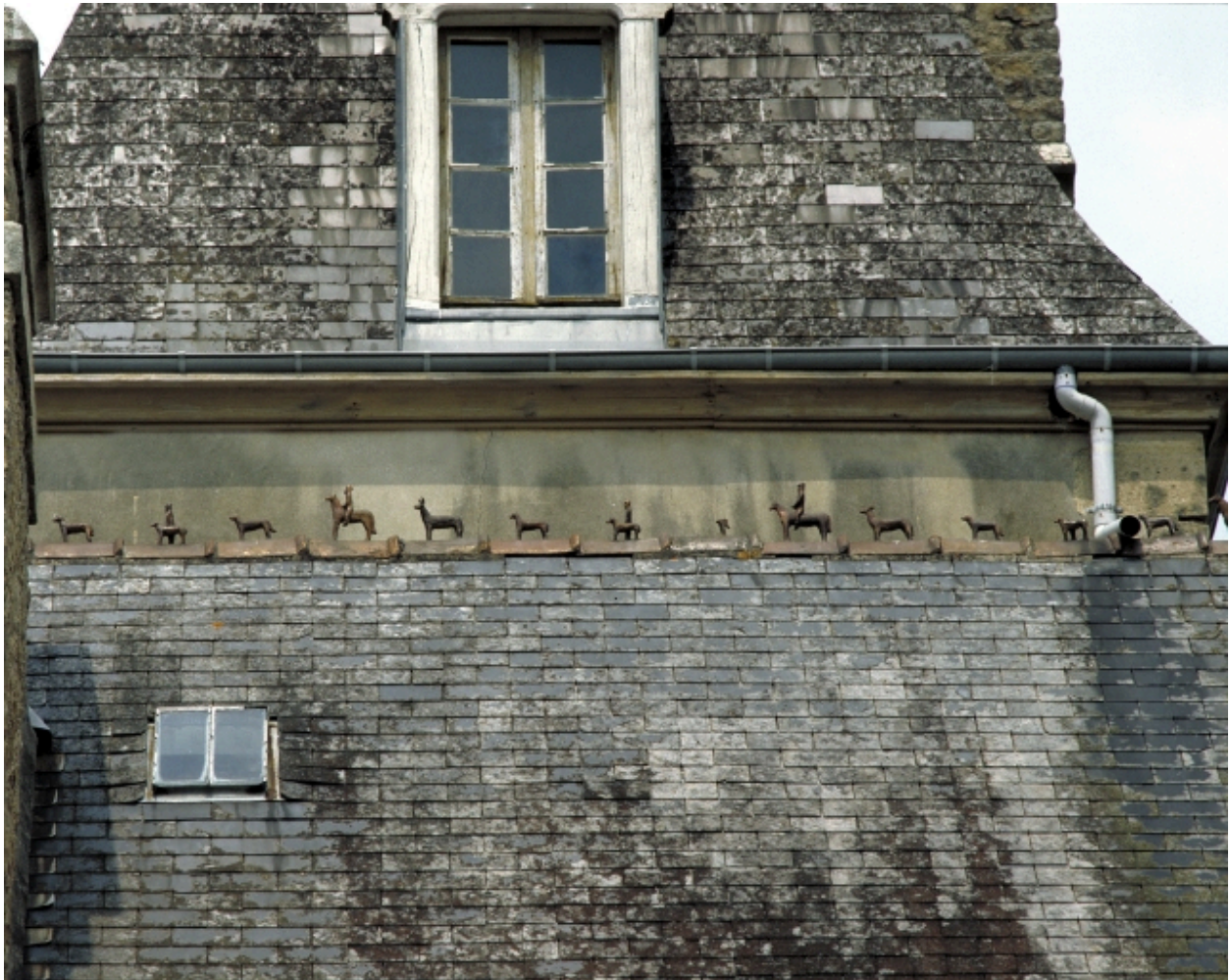
Détail du faîtage de l'aile ouest : chasse à courre
