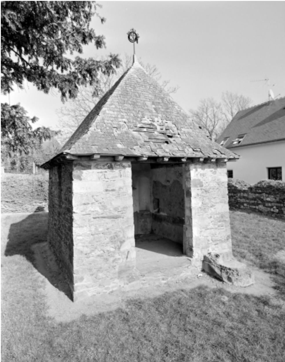
Elévation Sud : vue générale
