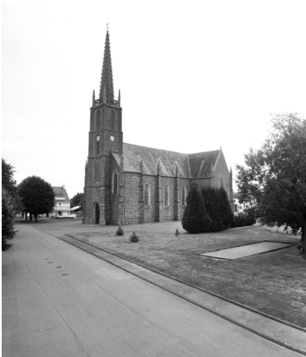
Vue générale : élévation sud-ouest
