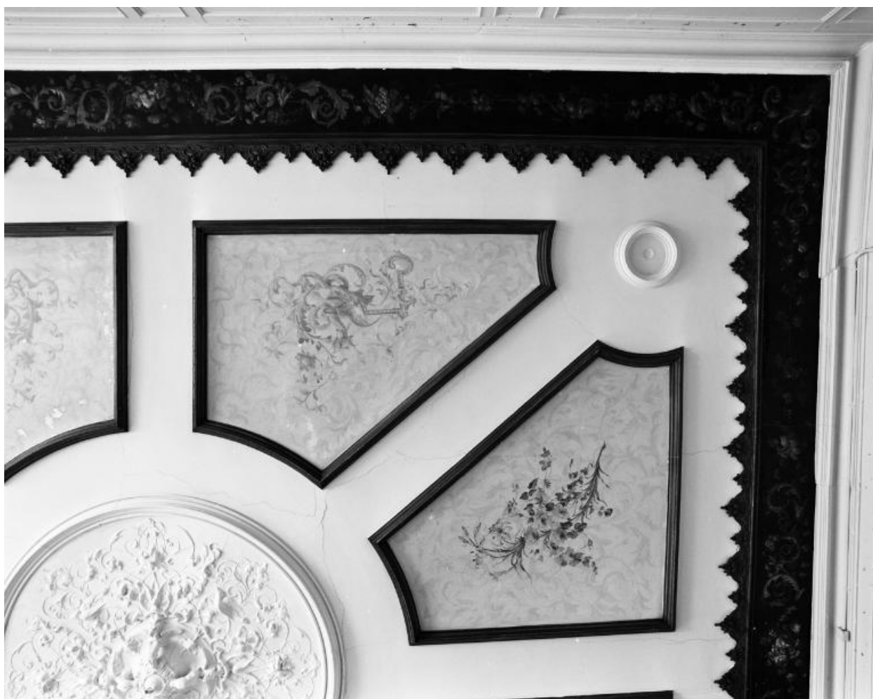
Château, rez-de-chaussée, salle à manger : décor du plafond, détail.
